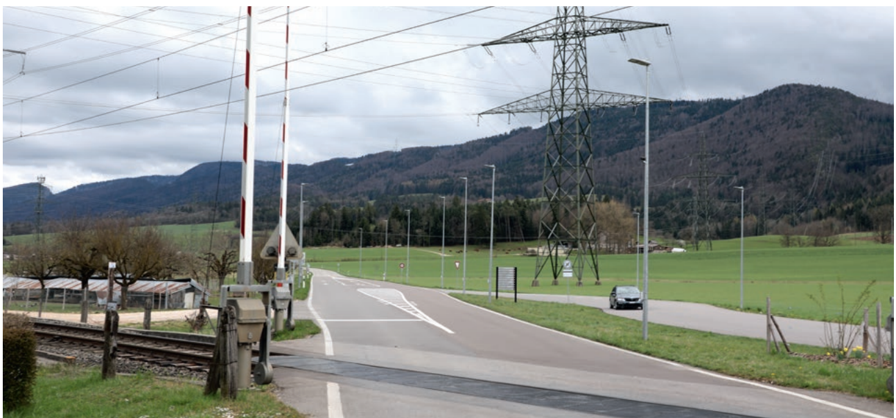
Assainissement sûr, même dans des situations plus complexes (proximité des chemins de fer et de diverses lignes à haute tension)
