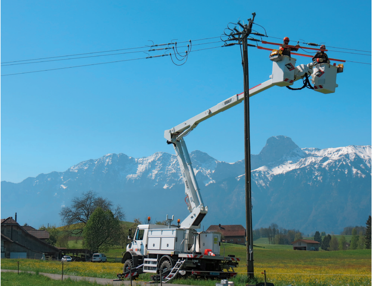
Betriebsunterbruchfreies Arbeiten an einer Mittelspannungsfreileitung
