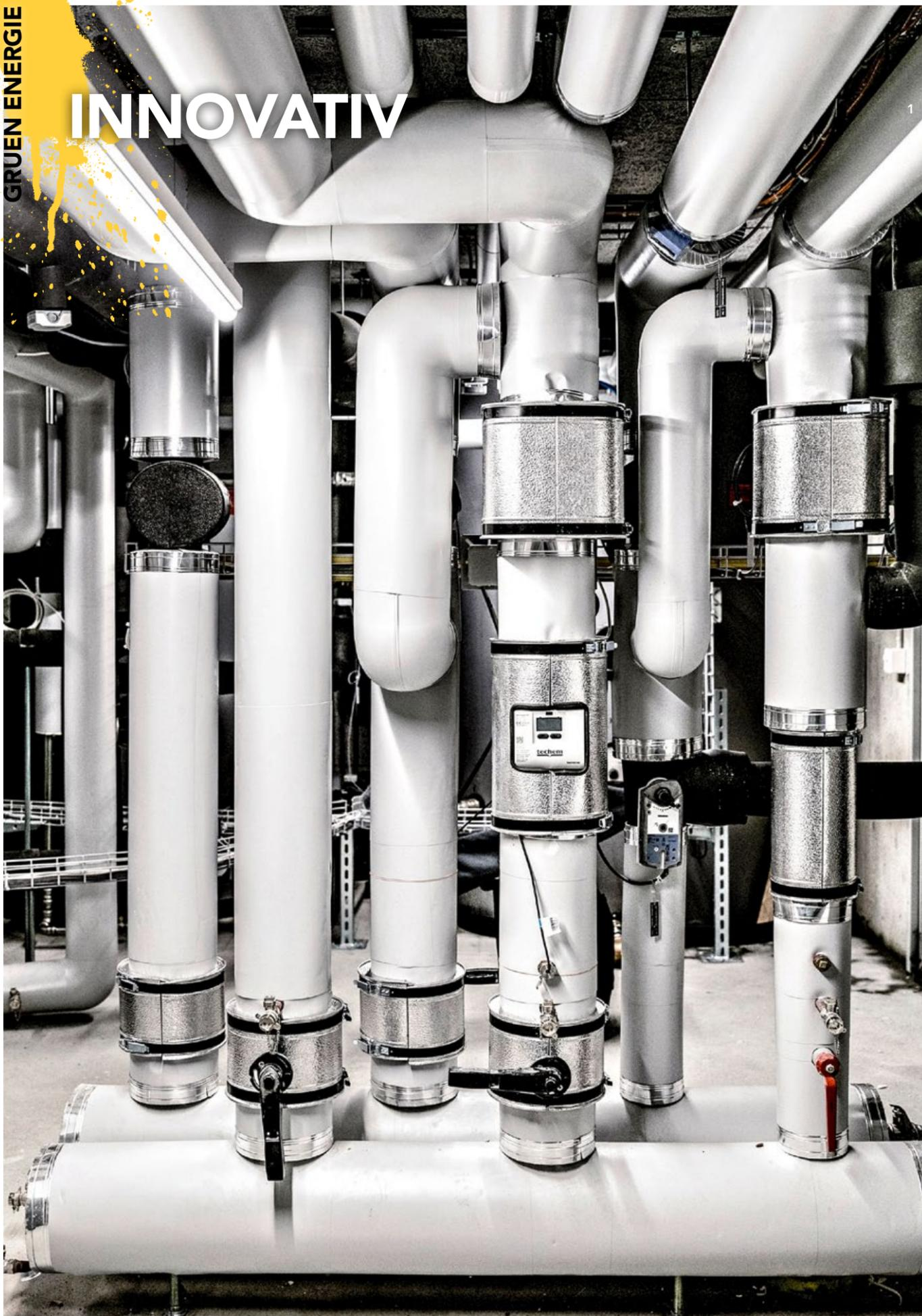
1 Kein Röhrensalat: Aus der Heizungszentrale wird die Energie in die 14 Wohnungen des Hauses verteilt.
