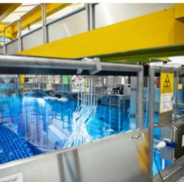
Das Brennelementlagerbecken wird seit September unabhängig von anderen Systemen gekühlt.
