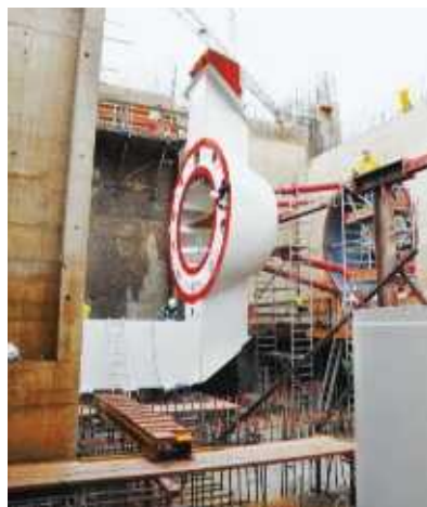
Centrale hydroélectrique de Hagneck: transfert d'un corps de turbine en décembre 2013
