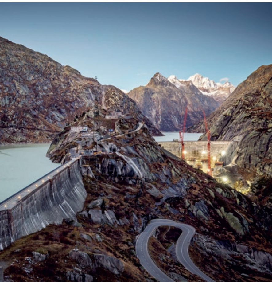
Le projet de centrale hydraulique à accumulation du lac de Grimsel est l'un de ceux que BKW veut promouvoir pour assurer l'approvisionnement en énergie de la Suisse pendant les mois d'hiver.
