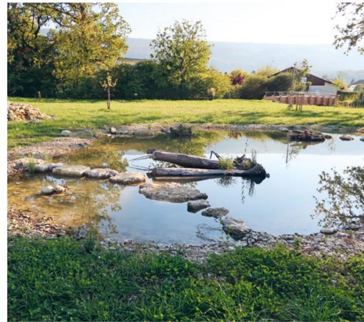
Zum Teil komplett unterspülte Mauern wichen im Zuge der Revitalisierung mehreren Steinschüttungen mit darüberliegenden Pflanzbetten. Fotos: © BIOTEC.
