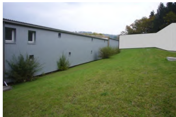
Abbildung 7.8-2: Böschung hinter Bürocontainer Süd (Foto verändert durch KKM am 16.10.2015)
