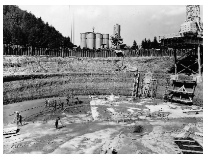
Début de la construction à Mühleberg
