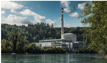
Das KKM ist der erste Leistungsreaktor der Schweiz, der stillgelegt wird.
