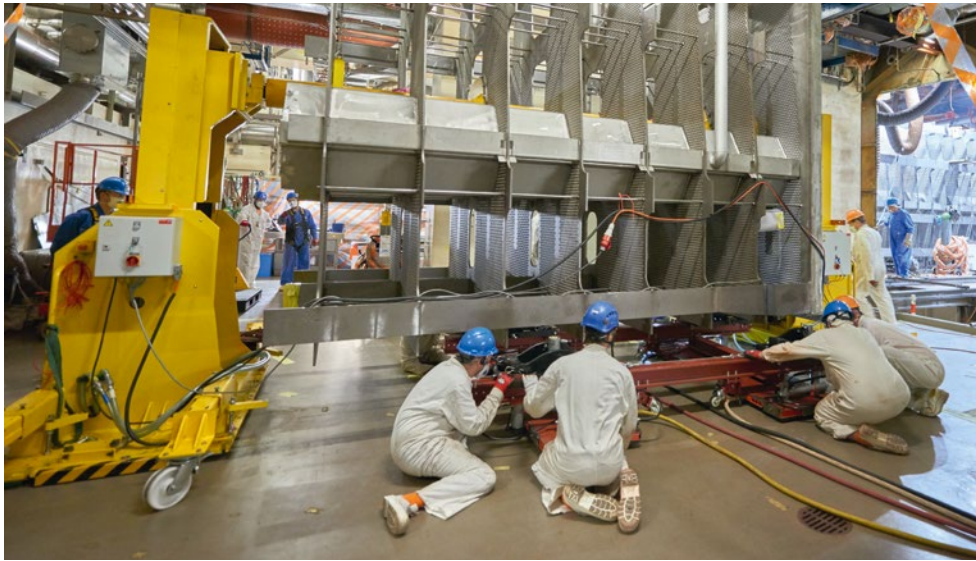
Millimeterarbeit für den Ersatz des Kondensators. Foto: KKL
