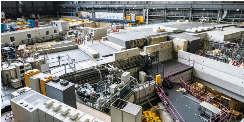
Experimentierhalle. Foto: Zwilag
