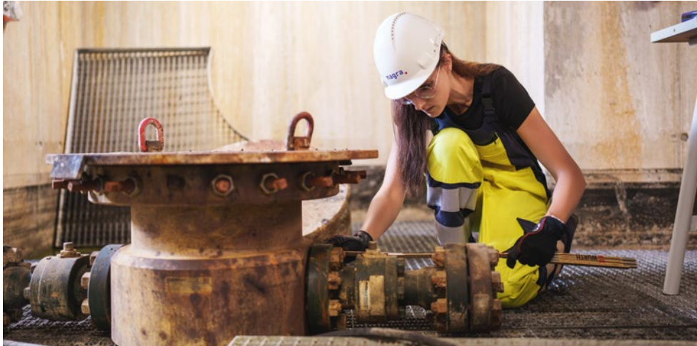
Arbeiten auf dem Bohrplatz Bachs. Foto: Nagra
