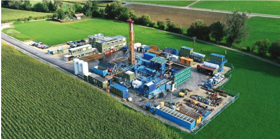
Bohrplatz Bachs. Foto: Nagra
