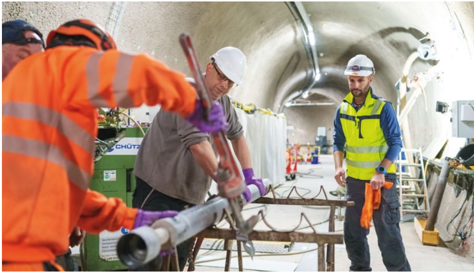
Arbeiten im Felslabor Mont Terri. Foto: Nagra
