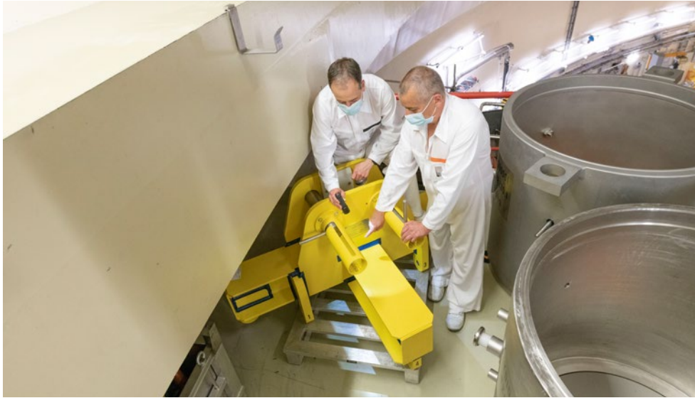
Im Ringraum des Reaktorgebäudes: Arbeitsvorbereitung für eine geplante Revision einer Traverse, die für die Demontage der Hauptkühlmittelpumpen benötigt wird. Foto: KKG
