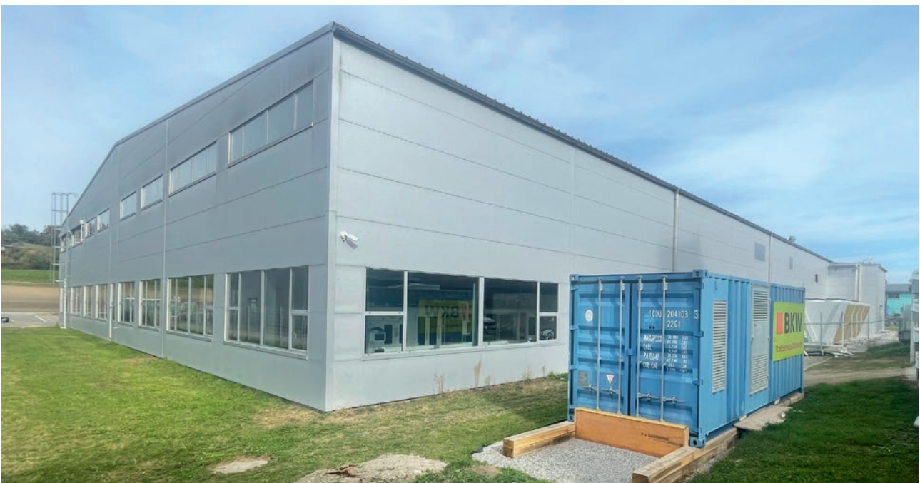
Produktionsstätte von 3S Swiss Solar Solutions AG in Worb mit mobiler BKW Trafostation
