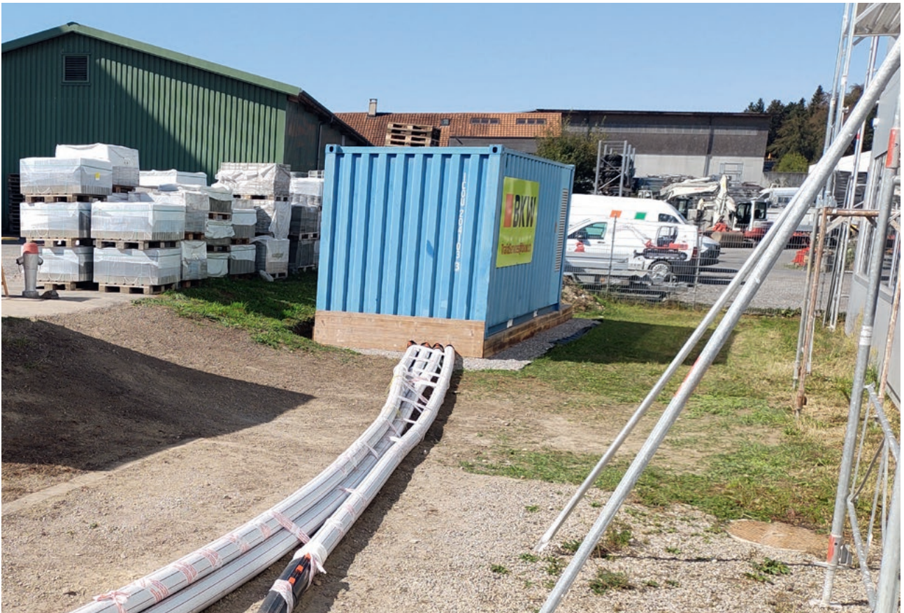
Anschluss der mobilen BKW Trafostation ans Mittelspannungsnetz
