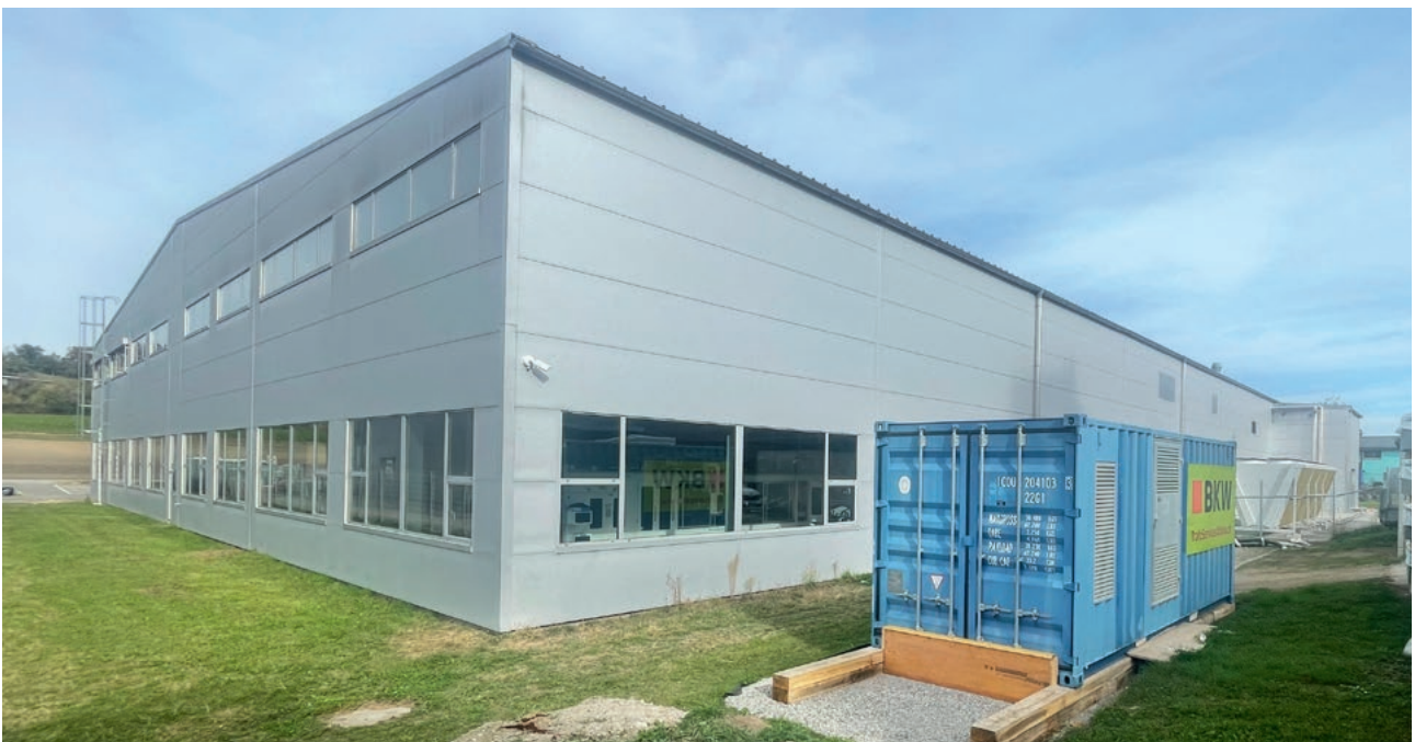
Le site de production de 3S Swiss Solar Solutions SA à Worb, disposant d'une station transformatrice mobile de BKW
