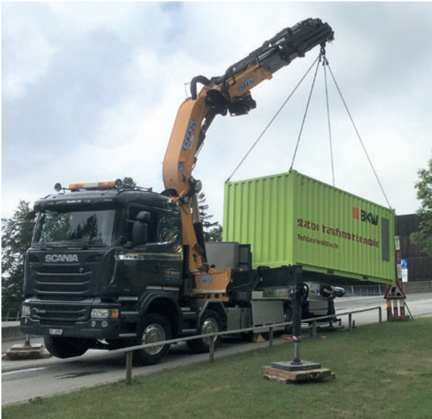
Livraison de la station transformatrice mobile de BKW chez un client du Pays des Trois-Lacs
