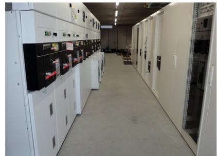
... avec 4 transformateurs de 1000 kVA et la nouvelle installation basse et moyenne tension
