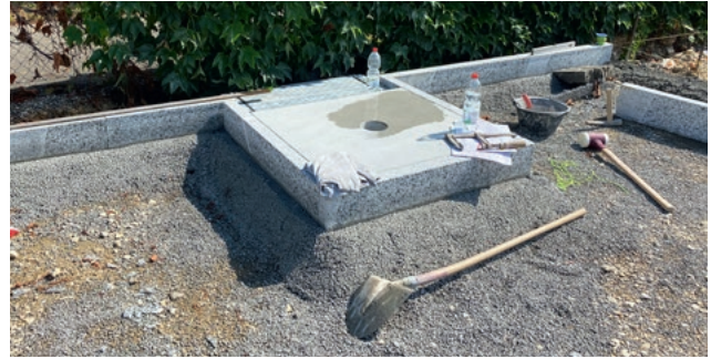
Einbau eines universellen Fundaments für Schnellladestationen
