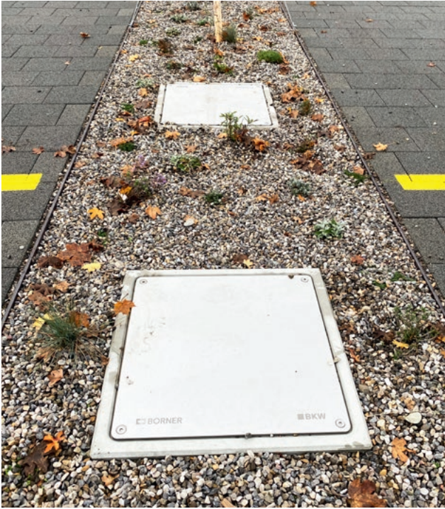
Vorbereitete, universelle Fundamente für spätere Installation von E-Ladesäulen
