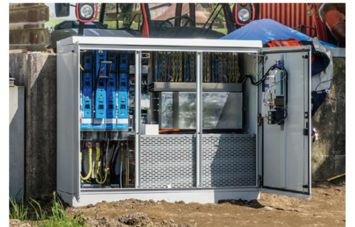
**Les RDB permettent de réguler la tension sur une ligne (valeur-cible à +/-10%) à partir des bobines des transformateurs et de composants de l'électronique de puissance. En aval de l'appareil, une grande plage de variation de tension demeure ainsi exploitable dans le respect des valeurs limites.**
