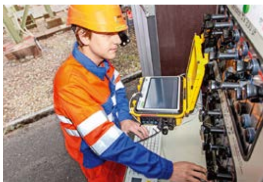
Instandhaltung von Anlagen und Leitungen
