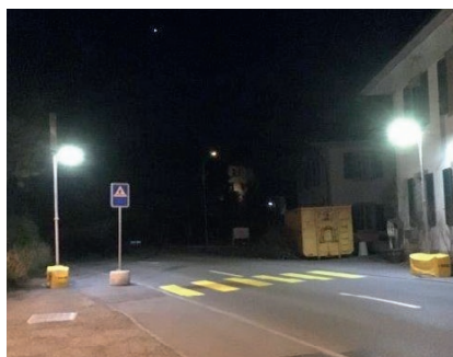
Anwendungsbeispiele: mobile Solarleuchten beim Fussgängerstreifen, fix installierte Solarleuchten bei einem Parkplatz oder bei einem Fussweg
