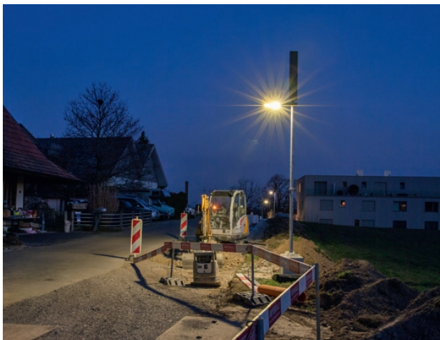
Baustellenbeleuchtung mit Solarleuchten
