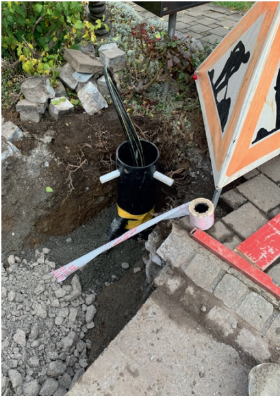
Tiefbauarbeiten bei netzgebundenen Leuchten
