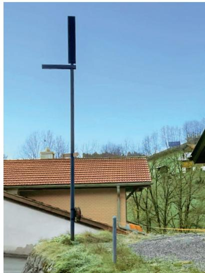
La photo de gauche montre l'ancien éclairage raccordé au réseau, suspendu au poteau basse tension. Le réseau aérien ayant été câblé, la commune s'est prononcée en faveur de luminaires solaires (voir photo de droite), notamment pour des raisons de coûts (travaux de génie civil). Sur l'image, les luminaires «aron» de photinus
