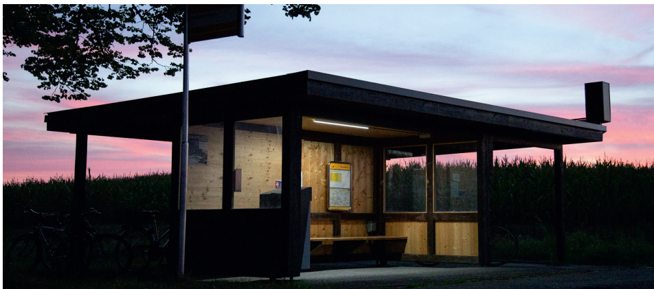
Luminaire solaire «mara» (installation fixe). Voir aussi «Référence Oberdettigen» sous www.bkw.ch/luminaireessolaires
