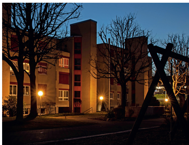
Les luminaires en place avaient une lumière mal centrée et provoquaient de fortes émissions lumineuses. Les chemins piétons et les places étaient mal éclairés.
