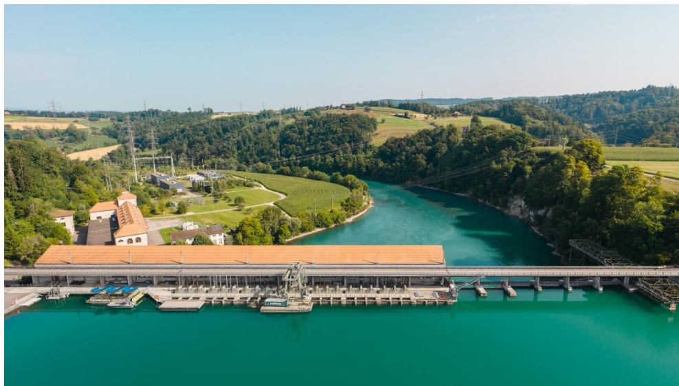
La centrale hydroélectrique et la sous-station de Mühleberg (© BKW, Daniel Hager)
