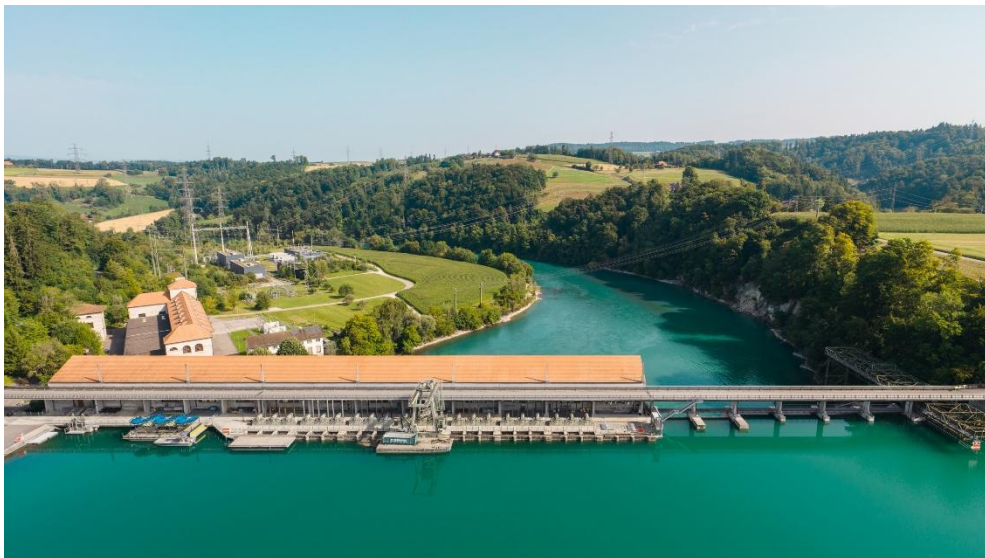
Das Wasserkraftwerk und die Unterstation Mühleberg (© BKW, Daniel Hager)
