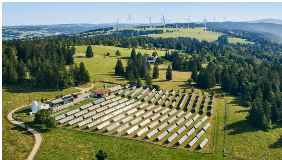
Die Photovoltaikanlage Mont-Soleil mit dem Windpark Juvent. ©BKW
