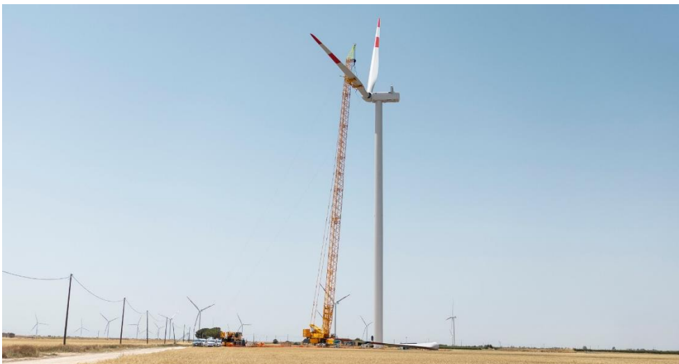
Montage von Rotorblättern im Windpark Cerignola in Italien © BKW
