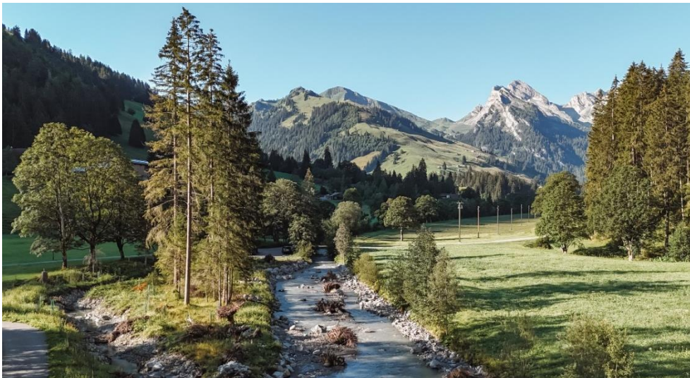
Der Kanal des Fildrich im Diemtigtal wurde mit Unterstützung des BKW Ökofonds revitalisiert.
