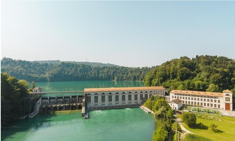
La centrale hydroélectrique de Mühleberg s'apprête à être entièrement modernisée. Photo: © BKW
