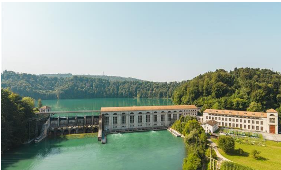
Das Wasserkraftwerk Mühleberg wird gesamterneuert. Foto: © BKW
