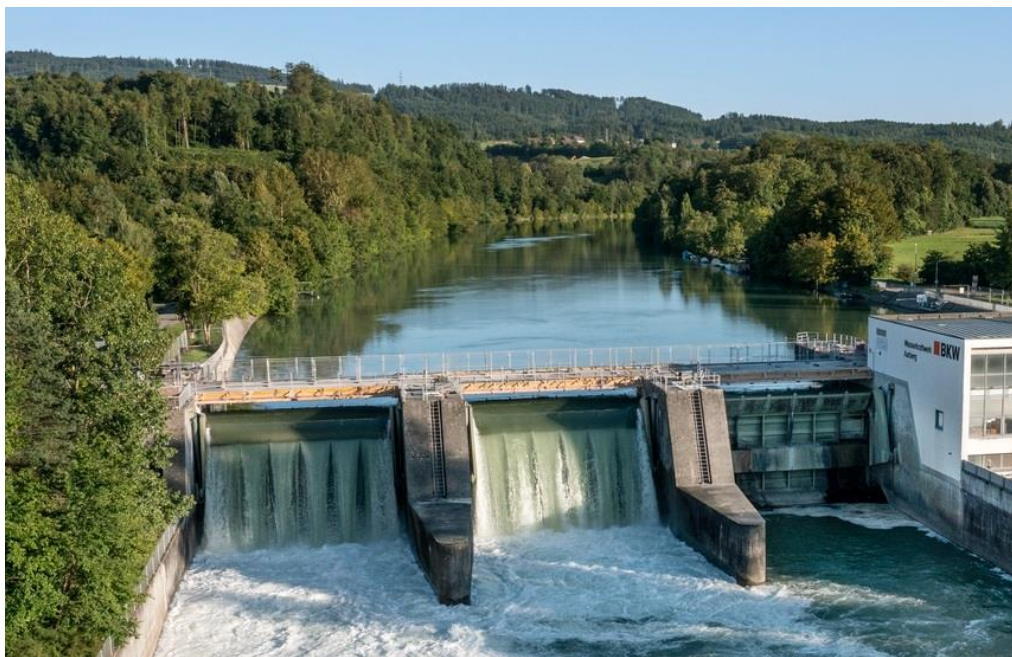
La centrale hydroélectrique BKW d'Aarberg. © BKW/ Peter Neusser
