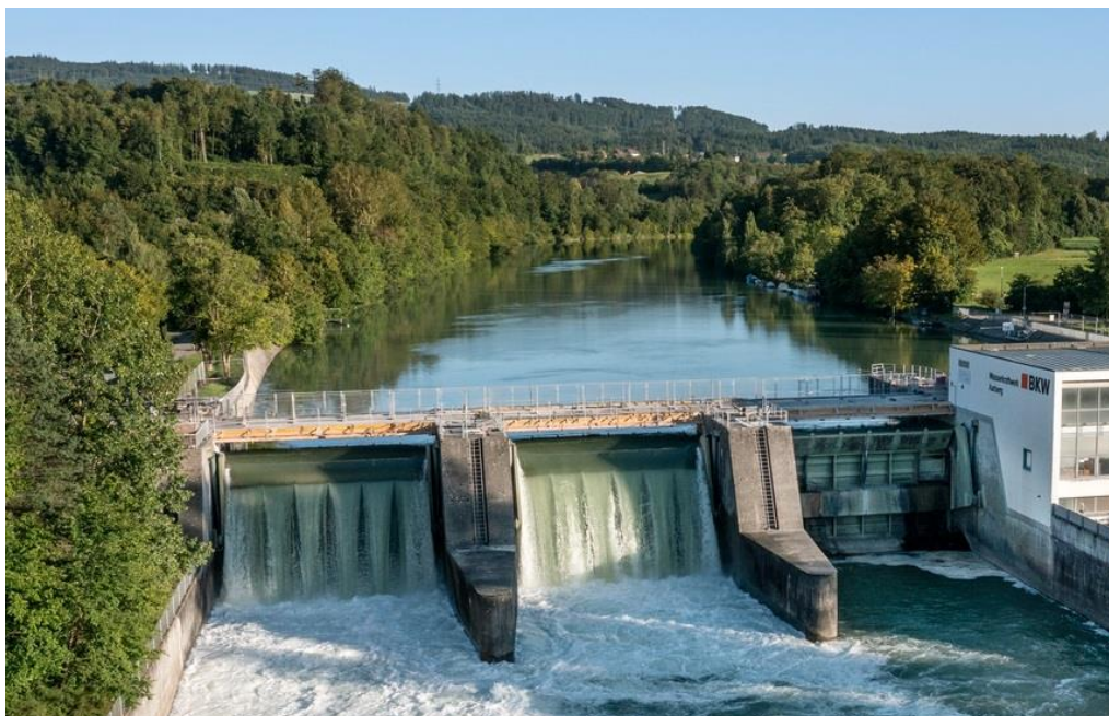
Das Wasserkraftwerk Aarberg der BKW. © BKW/ Peter Neusser
