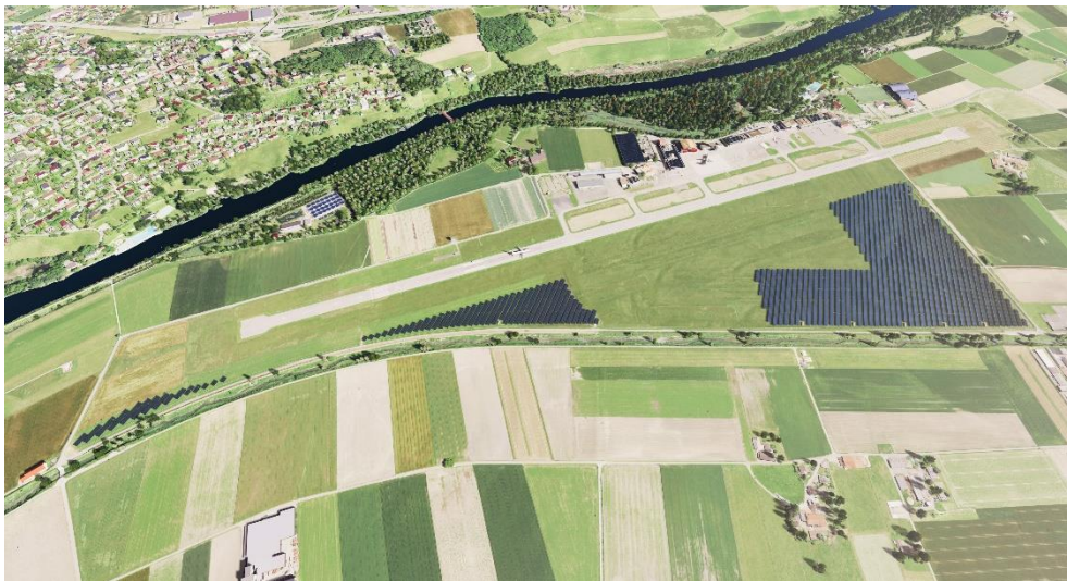
Das neue Layout des Solarkraftwerks BelpmoosSolar beim Flughafen Bern © BKW
