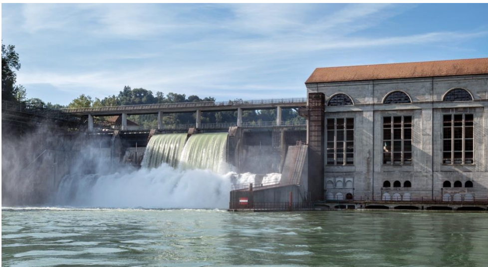
Das Wasserkraftwerk Mühleberg der BKW © Peter Neusser
