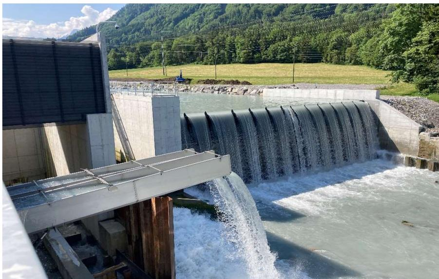
An der Kander in Wimmis, Aeschi b. Spiez und Spiez entstand in den letzten drei Jahren das Wasserkraftwerk Augand. Am 8. September ging das Kraftwerk mit einer Einweihungsfeier offiziell in Betrieb. Das Kraftwerk produziert jährlich rund 35 Gigawattstunden erneuerbaren Strom für die Region. Das entspricht dem Strombedarf von rund 7700 Vier-Personenhaushalten. Zwei Kaplan-Turbinen leisten dabei 7,4 Megawatt. Auf rund 68 Millionen Franken belaufen sich die Gesamtkosten des Baus.
