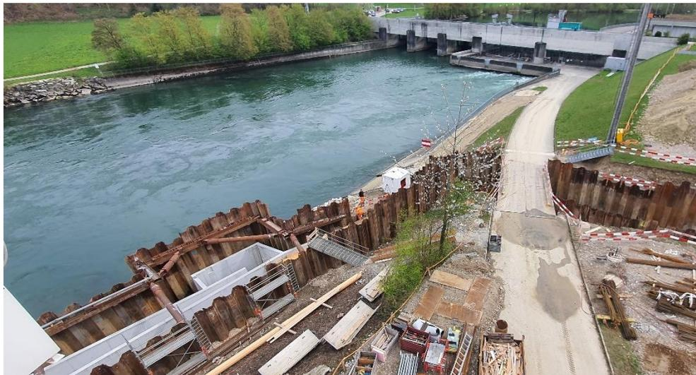
La construction de la passe à poissons avance: un des deux systèmes de montaison, déjà bétonné, est visible à gauche.
