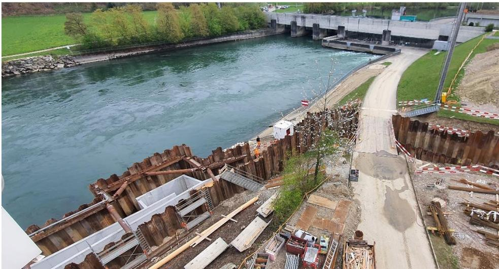
Der Bau des Fischpasses schreitet voran: links sichtbar und bereits betonierte einer der beiden Fischeinstiege.
