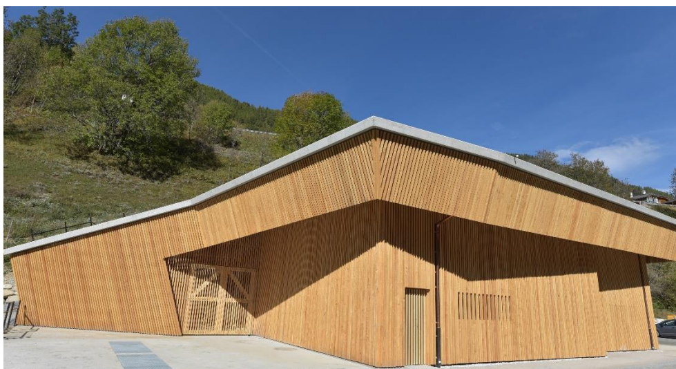
La centrale électrique de Wiler-Kippel.
