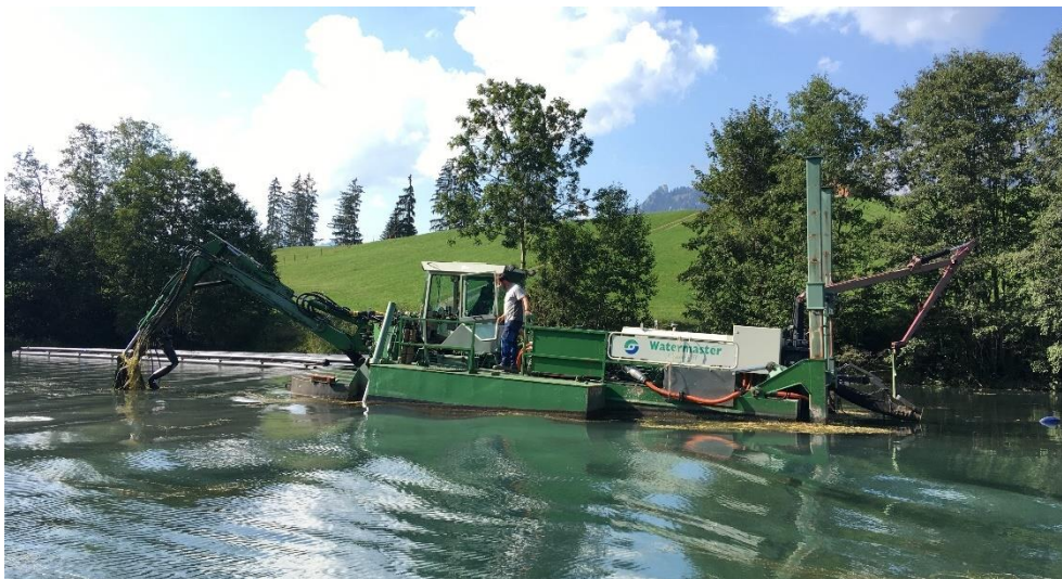
L'installation de drague flottante lors des tests à l'été 2020.
