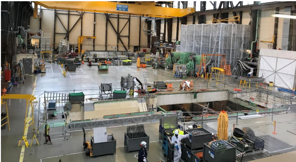
Im Maschinenhaus wurde Platz geschaffen, um hier das Material reinigen zu können.
