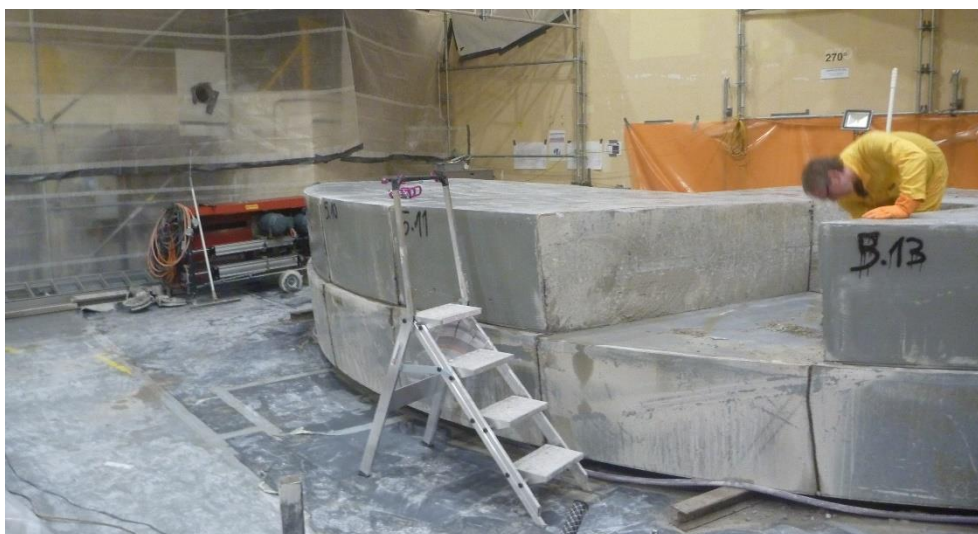
Oberhalb des Reaktors wurde nicht mehr benötigtes Material – wie hier die Abdecksteine – entfernt.
