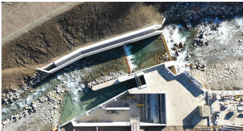
Die Wasserfassung des Kraftwerks Wiler-Kippel im Rohbau.
