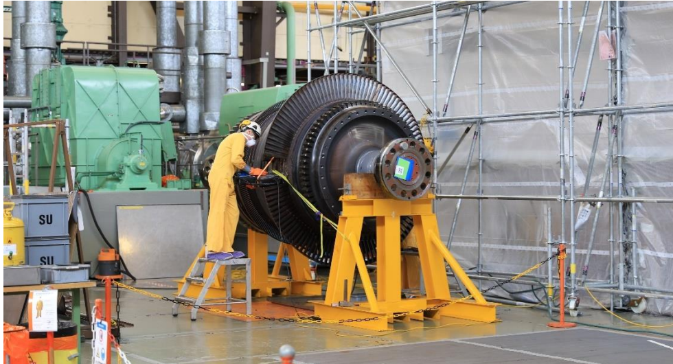
Travaux de démontage sur une turbine dans la salle des machines.
