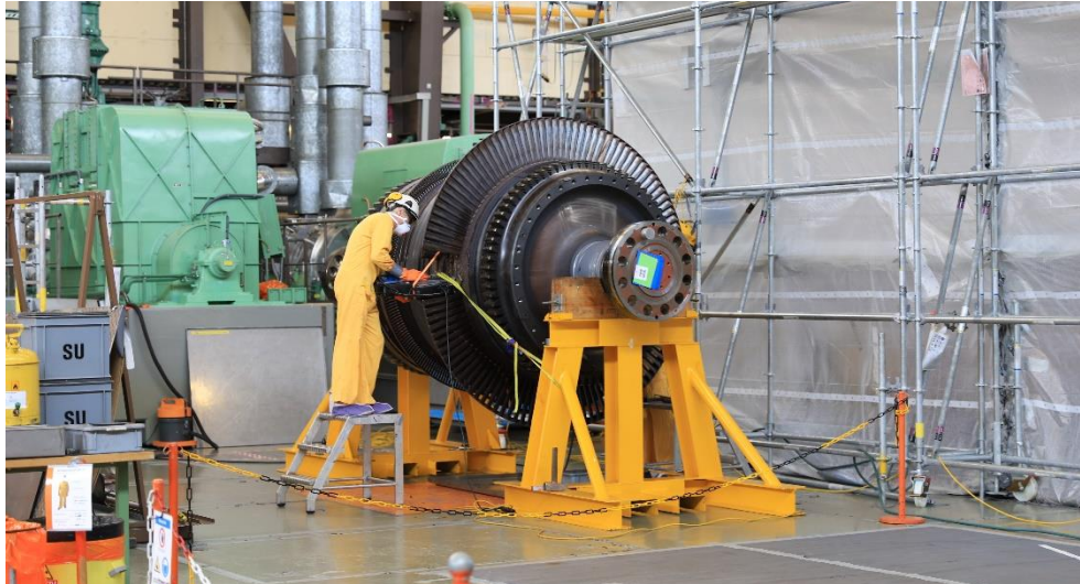
Demontgearbeiten an einer Turbine im Maschinenhaus.
