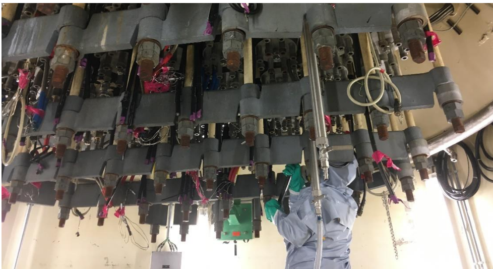
Ein KKM-Mitarbeitender beim Ausbau der Steuerstabantriebe.
