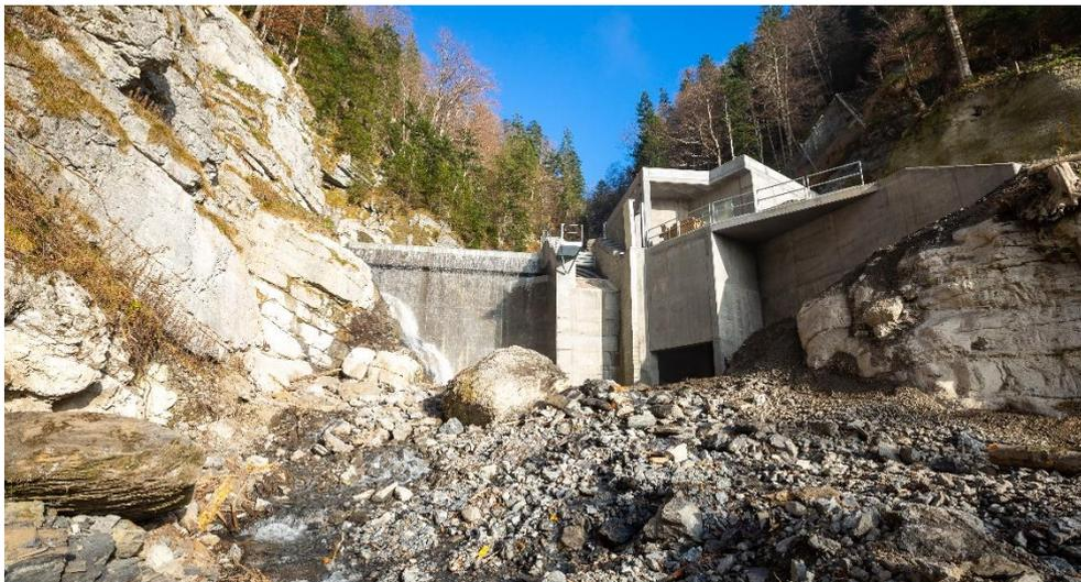
Der Berschnerbach wird auf 1'091 m ü.M. gefasst. Von dort fliesst das Wasser durch eine 1'275 m lange Druckleitung in zwei Turbinendüsen und so auf eine Pelton turbine in der Zentrale des Kraftwerks. Diese erzeugt mit einem Generator den Strom, der anschliessend weiter in das Stromnetz des Wasser- und Elektrizitätswerks Walenstadt eingespeist wird.
