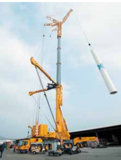
Der mächtige Teleskopkran.
