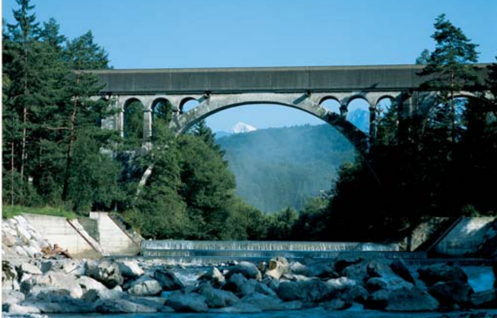
Aqueduc au-dessus de la Kander
