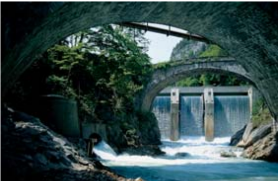
Barrage de la Simme à Wimmis
