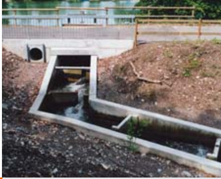
Biberpassage (runde Öffnung) und Fischpass beim Kraftwerk Aarberg
