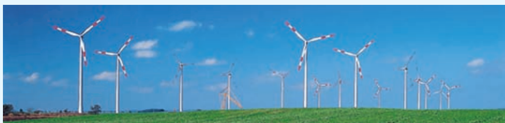
La dernière acquisition: le parc éolien de Lüdersdorf-Parstein.
